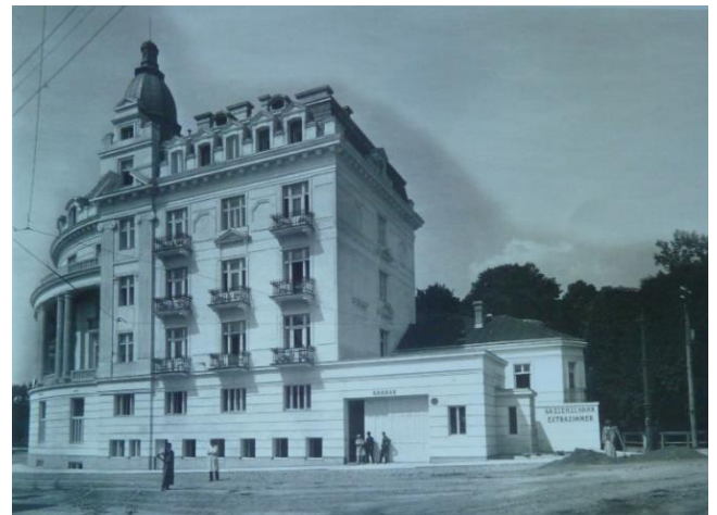
Hotel Esplanade, rechts Brücke über den Mühlbach Quelle: Stadtarchiv Baden
